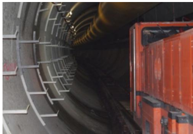
Sur le chantier du Lyon-Turin en 2014 (DR)
