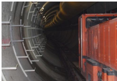
Sur le chantier du Lyon-Turin en 2014 (DR)
