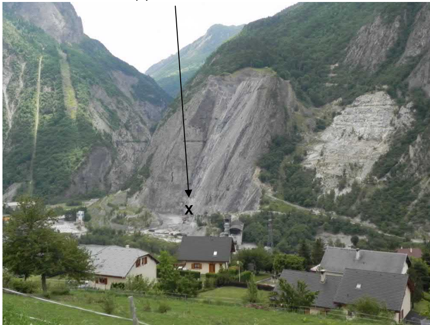
Proximité de la carrière (X) avec les habitations
