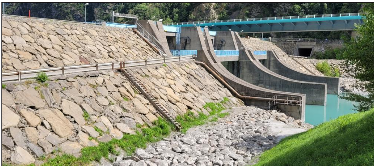
Le barrage du Pont-des-Chèvres, sur la commune d'Orelle.
