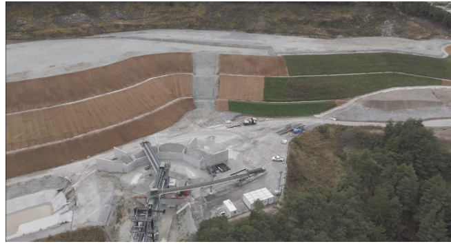
(b) Zone des Tièrces, Villarodin-Bourget, octobre 2024 (zone 1 sur la Figure 5) : verdissage sur fibre végétale pour l'intégration paysagère.
