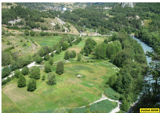
(a) Juillet 2009 (zone humide avant les travaux).
