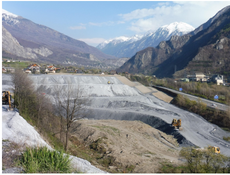
(a) Extension de la plage de dépôt des déblais, Saint-Julien-Mont-Denis, 2023.
